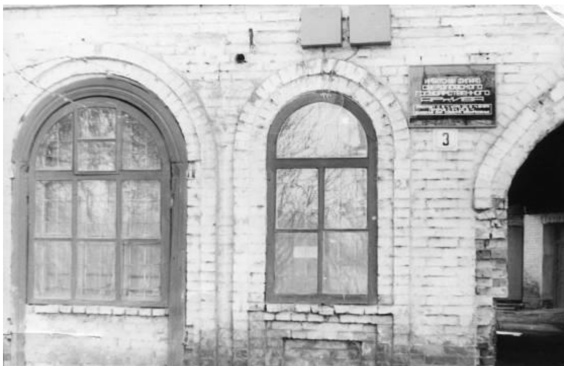
Фрагмент здания архива по ул. Красноармейской, д. 3. ГКУСО «ГА в г. Иrbите». Ф. К-1. Оп. 1-п. Д. 884-п.
