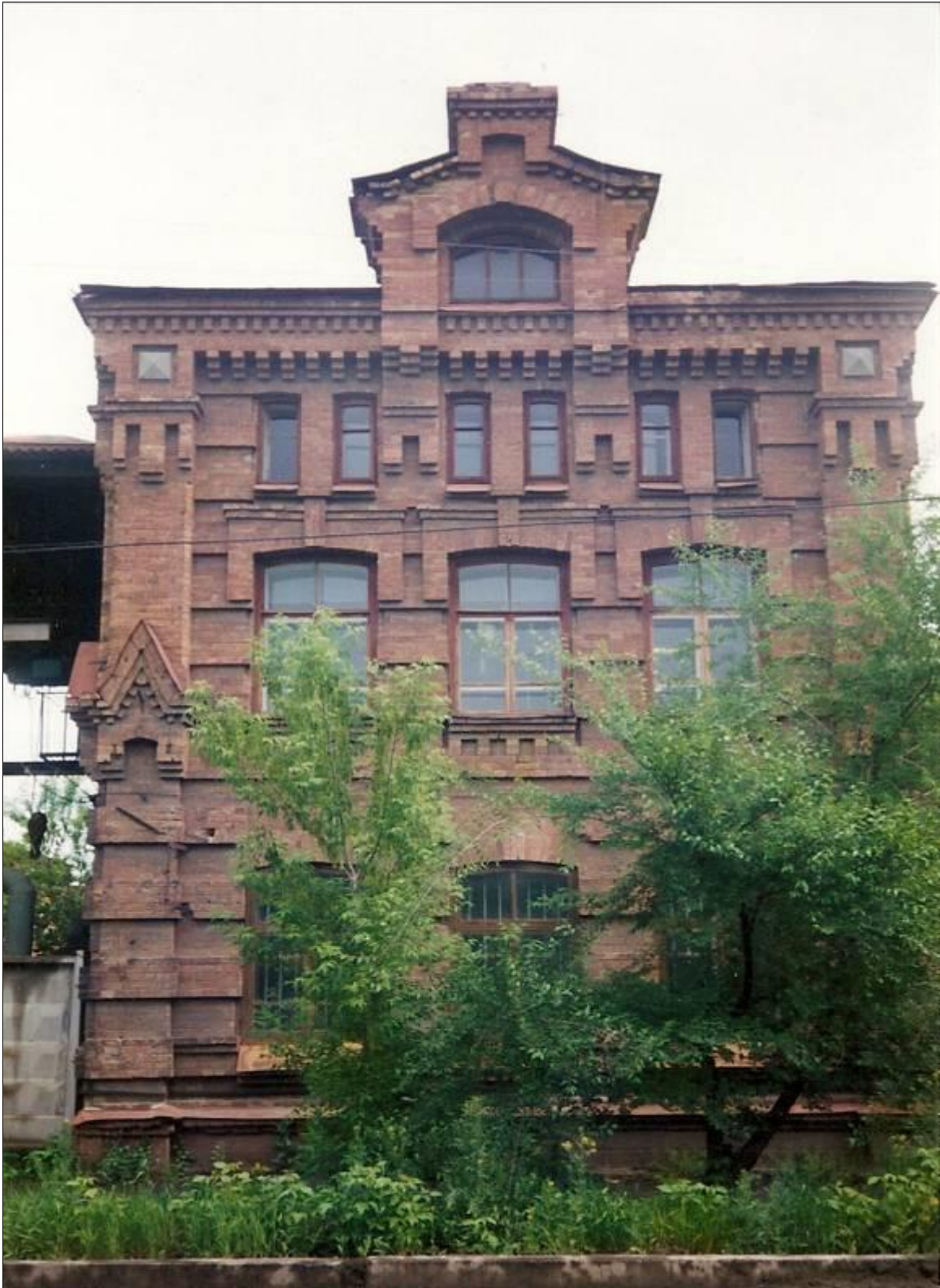
Общий вид цеха № 5 Ирбитского химико-фармацевтического завода ГБУСО «ГА в г. Ирбите». К.-1. Оп. 1. Д. 448п
