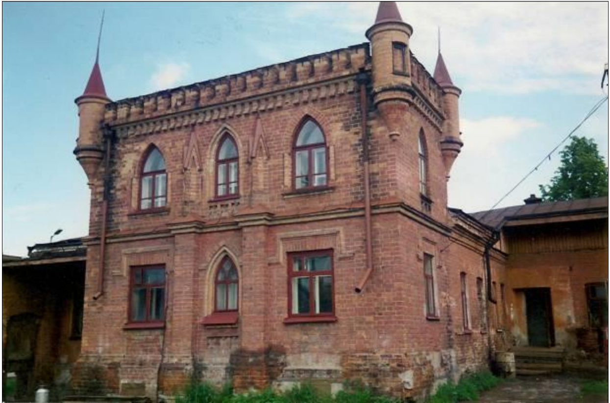
Общий вид дома. Бывший дом купца Колмакова. 2002 год ГБУСО «ГА в г. Иrbите». К.-1. Оп. 1. Д. 449п
