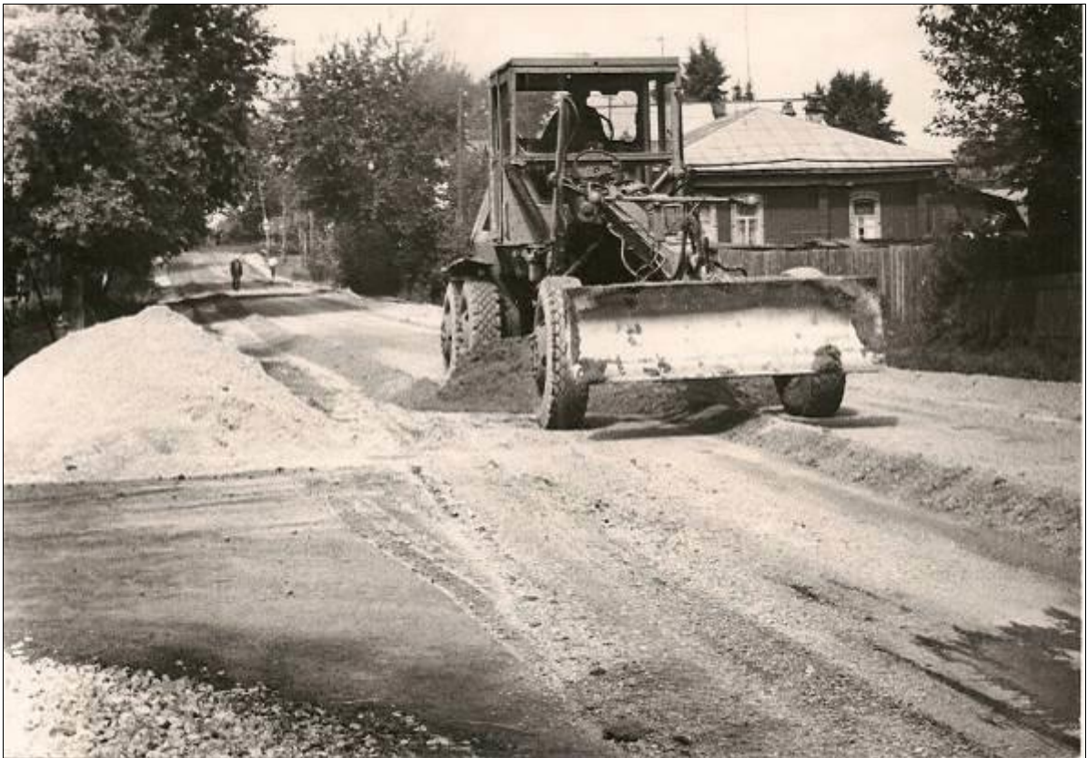
Строительство асфальтированной дороги по улице Р. Люксембург в г. Ирбите. 1992 год ГБУСО «ГА в г. Ирбите». К.-1. Оп. 1. Д. 270п
