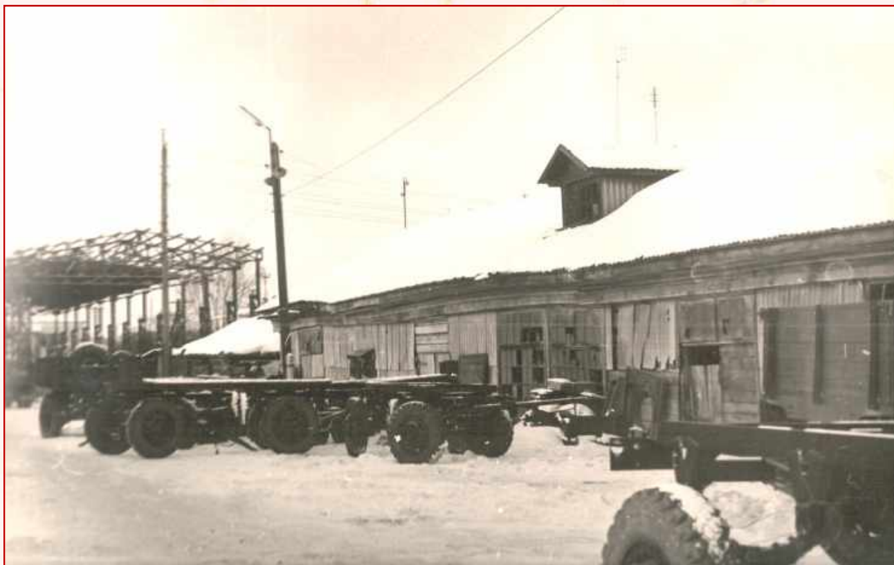
Склад горюче-смазочных материалов Ирбитского автоприцепного завода. 1975 год. ГКУСО «ГА в г. Ирбите» Ф. К-1. Оп. 1ф. Д. 218п.
