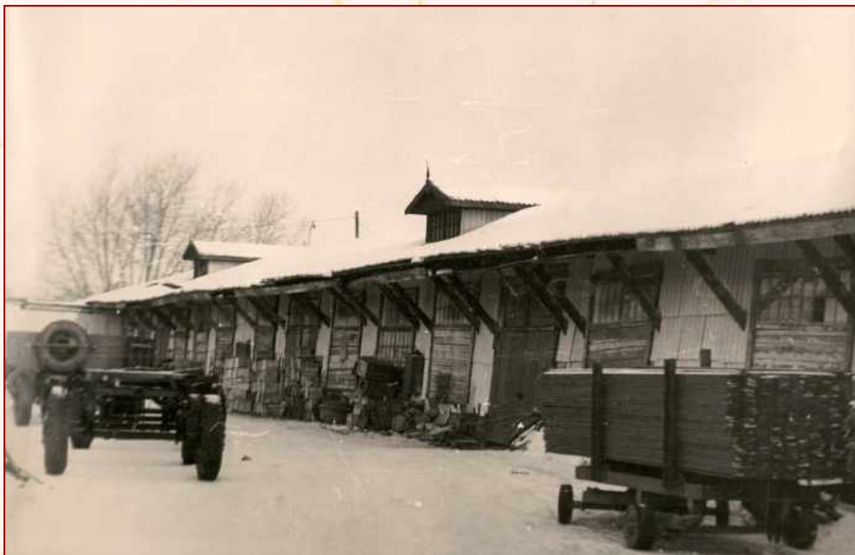
Склад горюче-смазочных материалов Ирбитского автоприцепного завода, 1975 год. ГКУСО «ГА в г. Ирбите» Ф. К-1. Оп. 1ф. Д. 220п.
