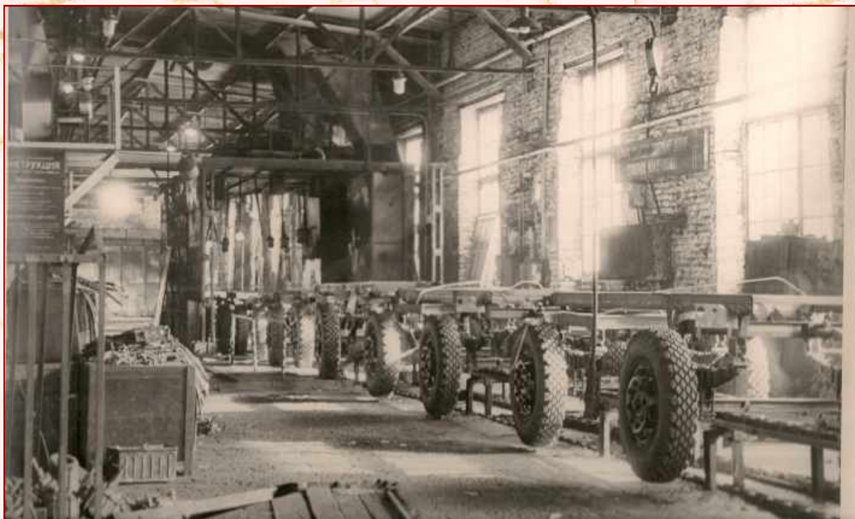
Сборочный цех Ирбитского автоприцепного завода, 1980 год. ГКУСО «ГА в г. Ирбите» Ф. К-1. Оп. 1ф. Д. 319п.
