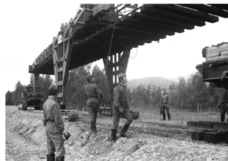
Укладка пути на Восточном участке БАМа. 1975 г. ГАХК
